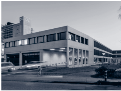
PARKHAUS MIT RETTUNGSDIENSTGEBÄUDE, SPITAL SRO AG LANGENTHAL, 2020
