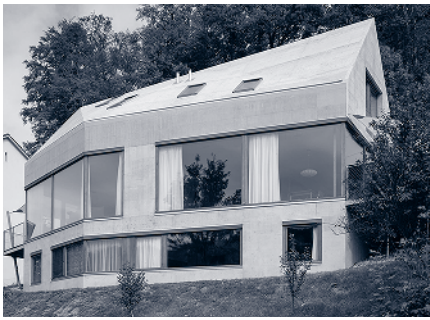
HÄUSER ALTE HOFSTETTERSTRASSE HOFSTETTEN-FLÜH, 2017
